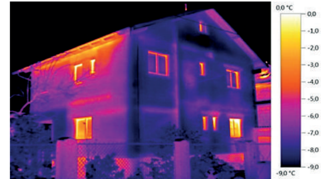
Bir binada yatay ve dikey ısı köprüleri.
